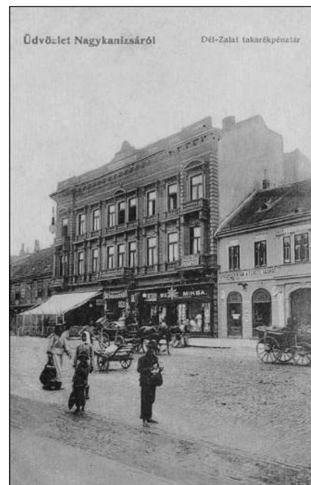
4. kép: A Dél-Zalai Takarékpénztár Fő úti székháza, a Bazárépület 1907 körül Képeslap, Weisz Lipót (Budapest) kiadása (TGYM Szombath-gyűjtemény)
