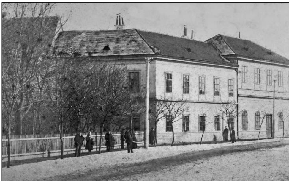
33. kép: A főgimnázium Eötvös téri épületének déli oldala, 1895 (TGYM T.2014.2.1.)
