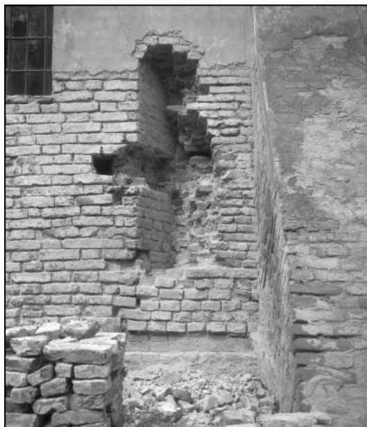
6. kép: A D-i hajófalban feltárt középkori szentélyindítás. (fotó: Gergelyffy András, 1971-1972. Forster Központ, Fotótár)
