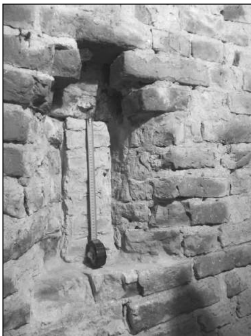
11. kép: A Ny-i homlokzat résablaka kibontás előtt a belsőben. (fotó: Simon Anna, 2014.)
