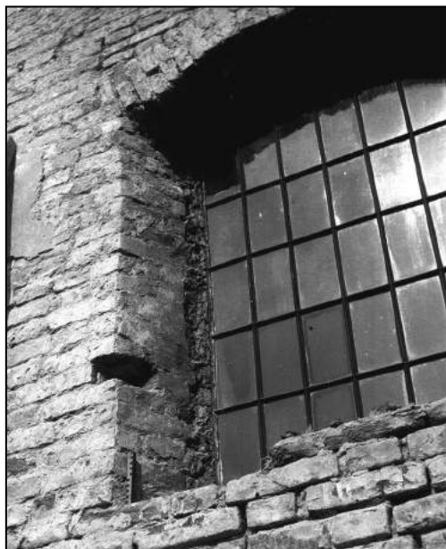
5. kép: A D-i hajófal középső ablaka, Ny-i kávéjában megőrzött középkori nyílásszél kváder-festésű középkori vakolattal. (fotó: Gergelyffy András, 1971-1972. Forster Központ, Fotótár)
