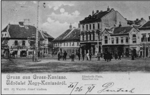
8. kép Az északkeleti oldal az 1890-es években. Bal oldalon a Csoportházakhoz tartozó egyemeletes épület látszik, középen a kváderezett földszintű Benzián-ház, majd az Arany Szarvas Szálló két- és egyemeletes épülete következik. Az 1894-ben üzembe helyezett ívlámpa mellett még ott áll a petróleumlámpa. (Képeslap, Thúry György Múzeum)
