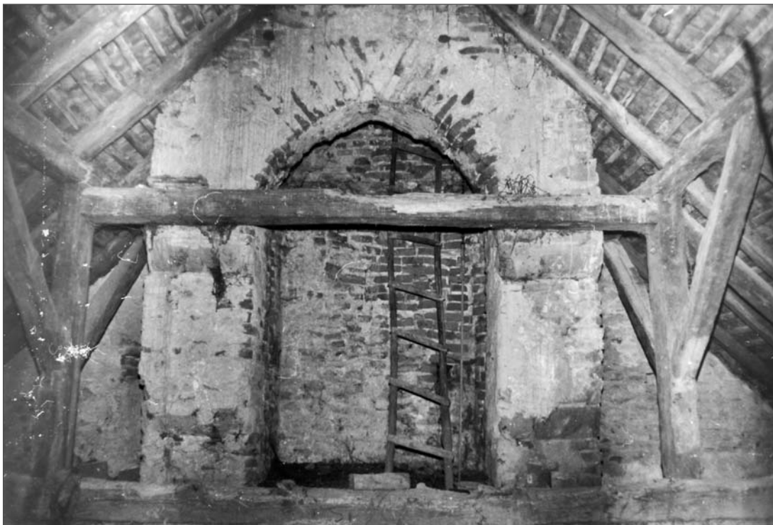
6. kép: A nyugati torony csúcsíves belső lezárása
