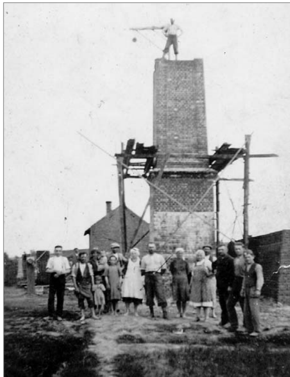
2. kép: A Szabó testvérek téglagyára a kémény építése közben (amatőr felvétel, 1940.)
