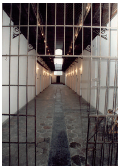
2. kép – Börtönfolyosó a felújítás után
