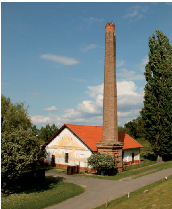
6. kép – Belvizeket átemelő egykori Hosszúfoki gőzüzemű szivattyútelep a Körösök vidékén (Vizy Zs. felvétele)
