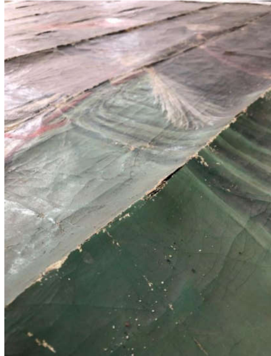
6.: Gyűrődések, kipergések, szakadások
